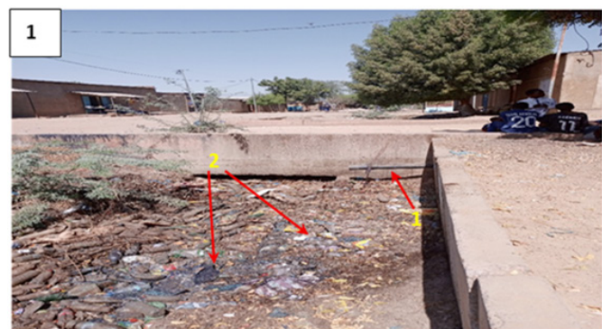
Photo 1 : Connexion d'une toilette à un canal : 1. : Tuyau de connexion Toilette – Canal, 2. : Eaux usées et ordures.
