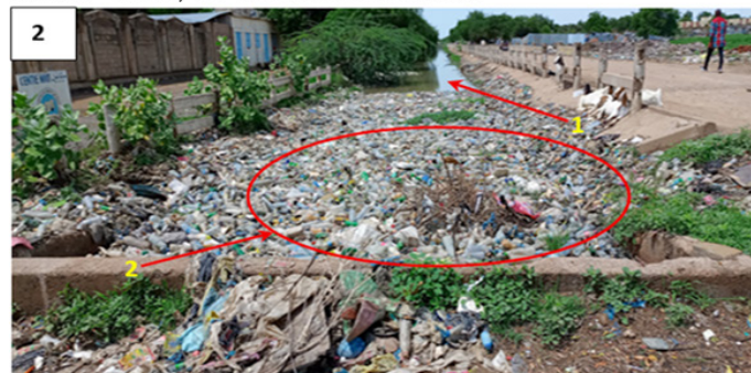
Photo 2 : Canal primaire obstrué par les eaux usées et ordures : 1. : Ecoulement laminaire, 2. : Bouteilles, sachets en plastique
