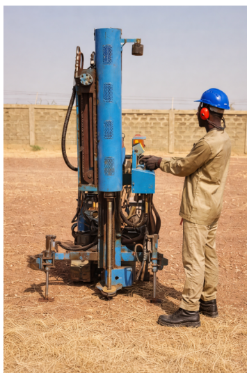
(a) Mise en œuvre de l'essai de pénétration dynamique.
