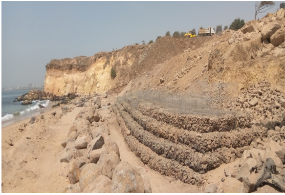
Figure 7 : Installation d'un ouvrage de protection en pied de pente
