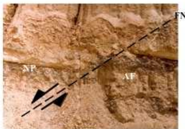
Photo 4 : Déformations dans le complexe phosphaté de Hahotoé-Kpogamé (NO de la Carrière de Kpogamé). NP : Niveau phosphaté ; AF: Argillites feuilletées; FN: Faille normale
