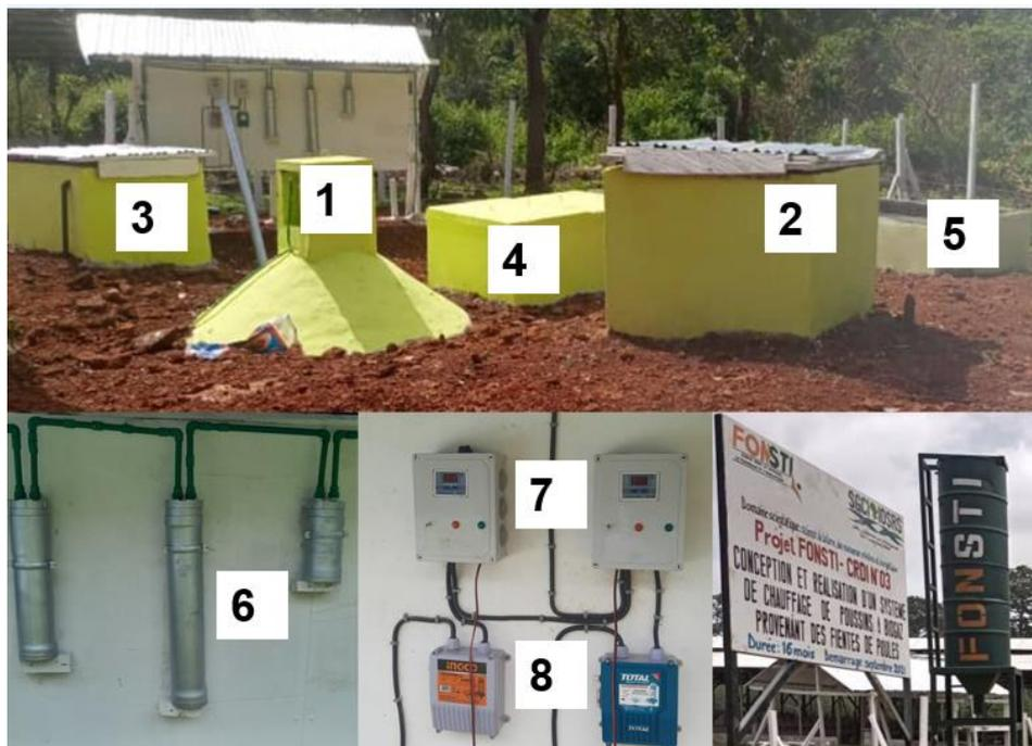
**Fig. 1.** Vue d'ensemble du prototype du biodigesteur réalisé.
