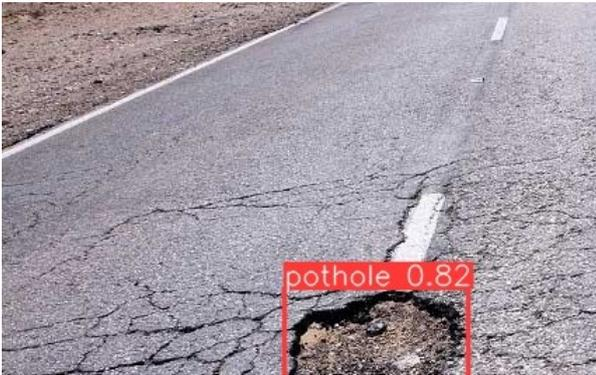
Figure 7 : image de détection de nid de poule
