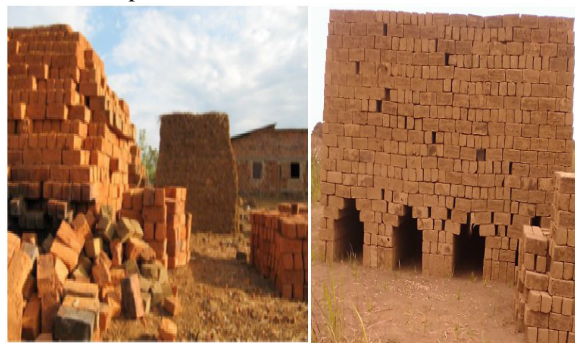
Figure 1: Four des briques dans la Bouenza
