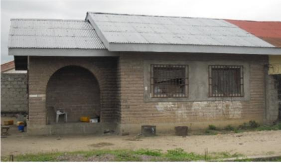
**Figure 1. Problèmes d'usure et d'émiettement des briques sur façades extérieures d'une bâtisse en terre stabilisée à Brazzaville (construite en 1997)**
