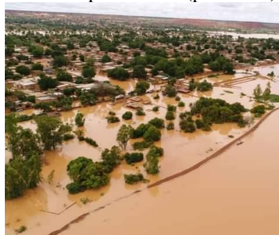
Rupture de la digue de protection en Août 2020 . Source : AGRHYMET
